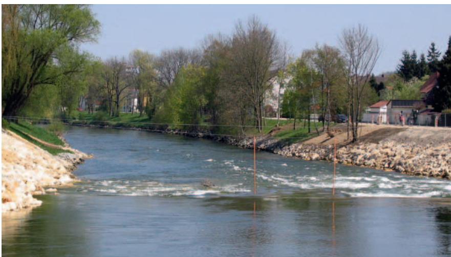
Links: Aufgelöste Sohlrampe mit Bootsgasse (Foto: WWA Landshut)
